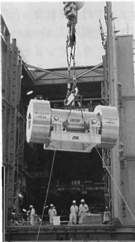
「むつ」使用済燃料の陸揚げ作業状況
